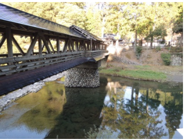
三嶋神社に至る木橋 隈研吾さんの作品で、屋根のある 木橋です。地元の方が頻繁に 訪れ、良く手入れされています
