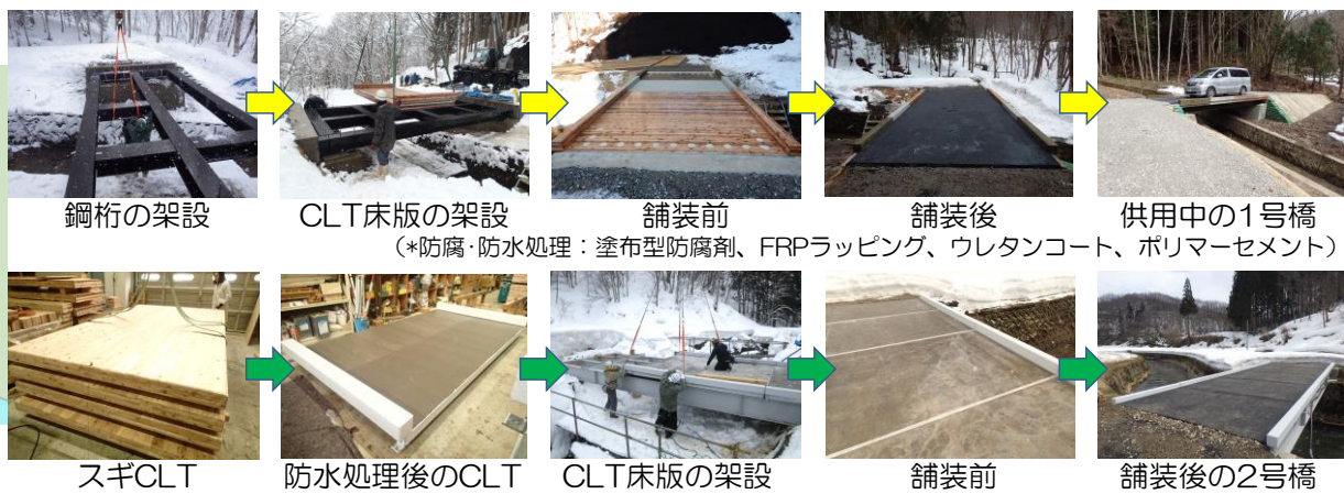
図7. CLT床版を用いた橋梁の試験施工 (*防腐・防水処理: ポリマーセメント)
