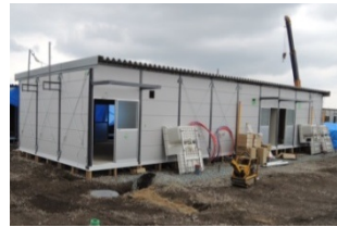
鉄骨プレハブ仮設住宅 (建設中)
