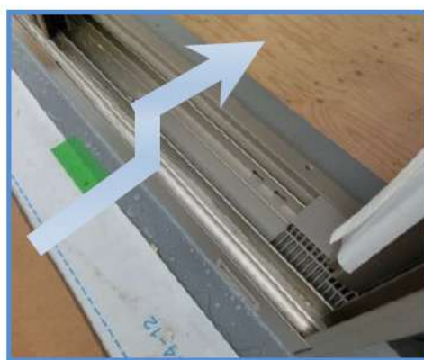
防水先施工の施工写真例
